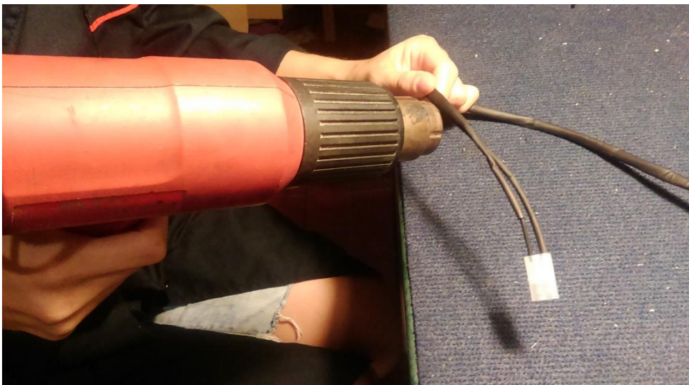
14. Spajanje kablova na naponskom pretvaraču el. en. lemljenjem i stavljanje termo bužira
