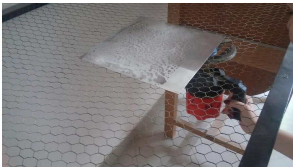
Slika 8 : Fiksiranje asfaltnog praha matrice pomoću plamenika.
