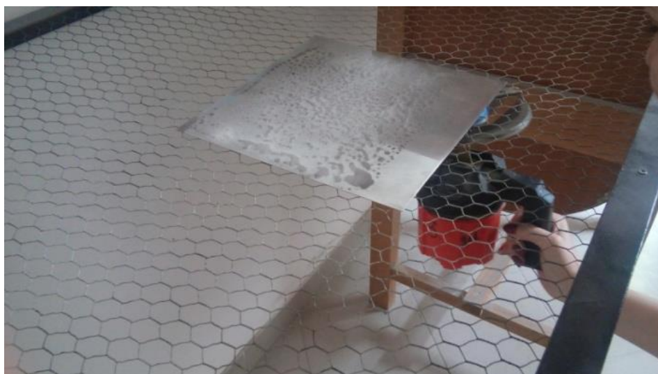
Slika 8 : Fiksiranje asfaltnog praha matrice pomoću plamenika.
